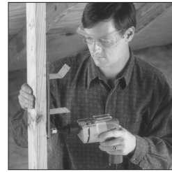
Fixer le support de montage (MB).
