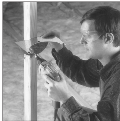
Fixer le support de montage (NB)
