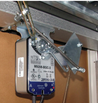
Figure 5. Moteur et tringlerie de registre modèle CAUA à l'intérieur de la boîte de mélange
