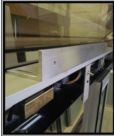
2 – 3 Position AMB at center of header
