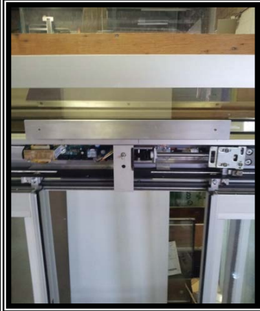
2 – 3 Position AMB at center of header
