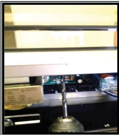
4 Drill AMB mounting holes
